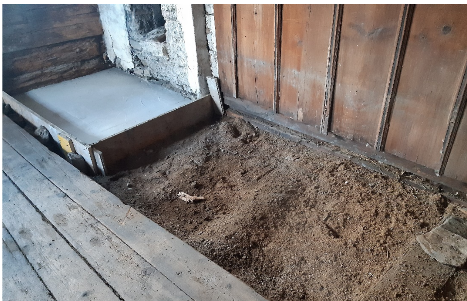
Die Bodenplatte in der Stube im OG ist bereit für den Nachbau des vor Jahrzehnten abgerissenen Ofens.
