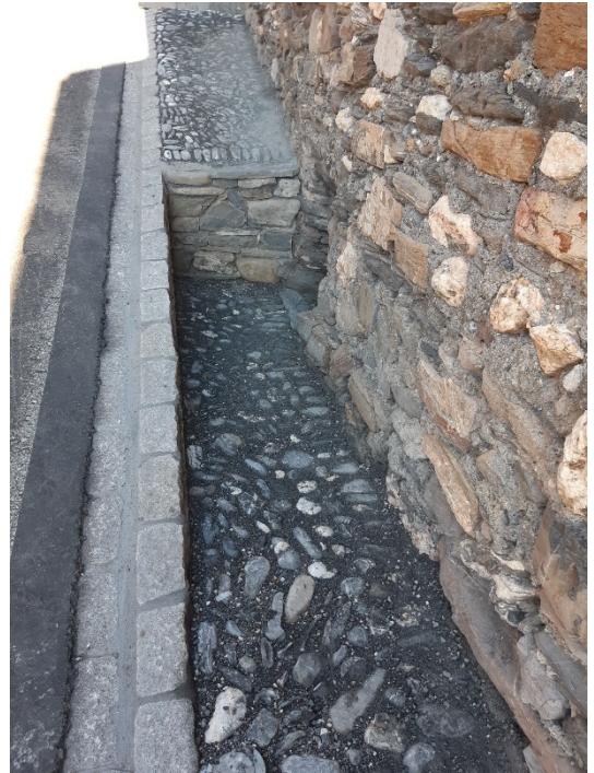
Kirchweg während und nach der Sanierung mit der gelungenen Bollensteinpflasterung entlang dem Jooshuus.
