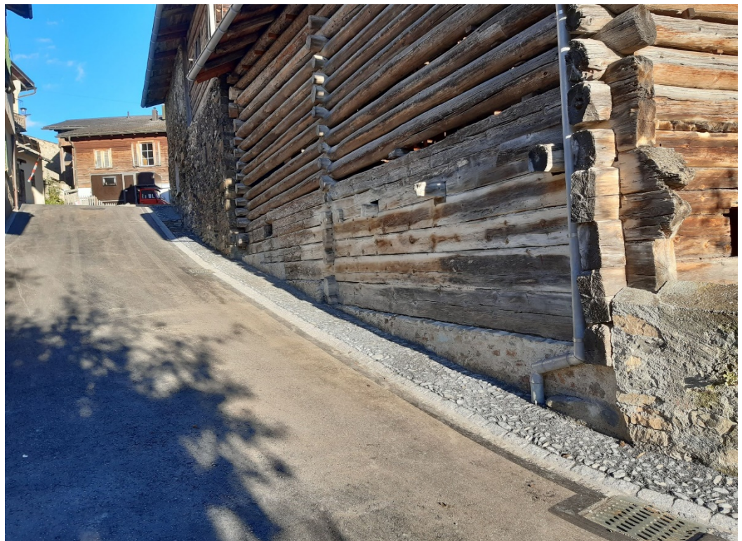
Kirchweg während und nach der Sanierung mit der gelungenen Bollensteinpflasterung entlang dem Jooshuus.
